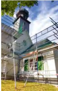
Im Sommer traten bei den Reparaturarbeiten des Hagel-schadens von 2023 an unserer Kirche in Kochel unvorhergesehen tragende Balken zu Tage, die sich durch einen früheren Wasserschaden zersetzt
